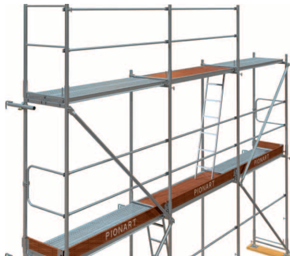
Rys. 19. Montaż ramki górnej
