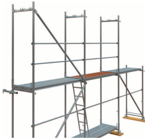
Rys. 13. Montaż stężenia ukośnego drugiej kondygnacji
