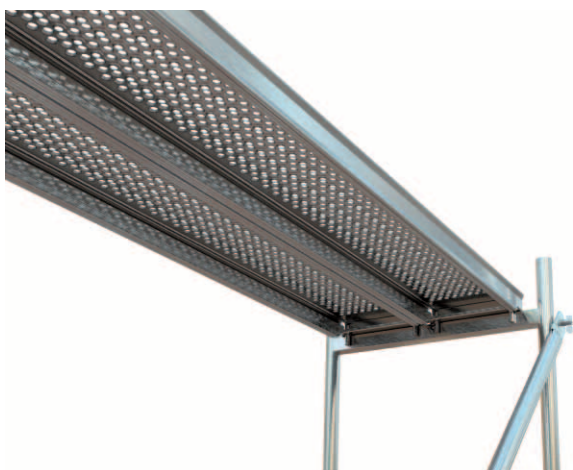
Rys. 6. Montaż pomostów stalowych pierwszego pola rusztowania
